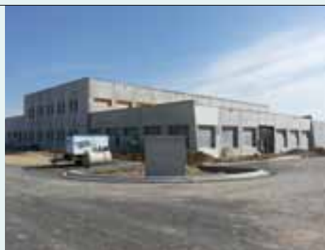
建設中の新社屋
