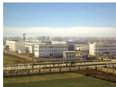
建設が進むAEMC新工場
