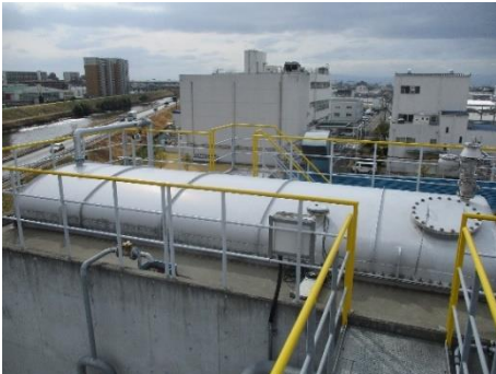
廃水処理設備 嫌気処理槽
