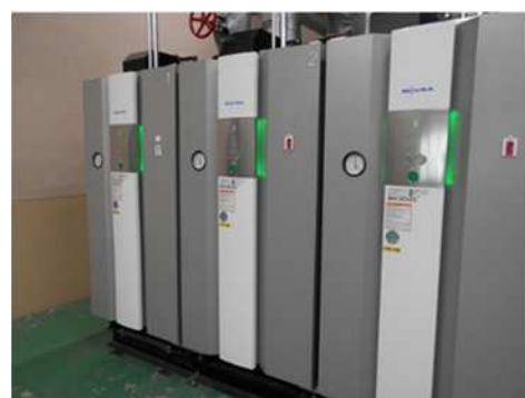
ボイラー更新 (滋賀工場)
