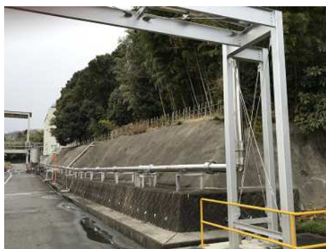
重油ボイラー廃止に伴う 蒸気配管の新設 (養老工場)
