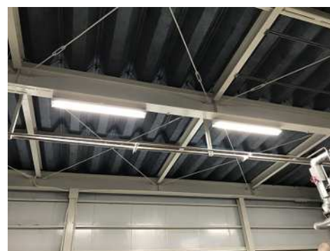
照明LED化 (養老工場)
