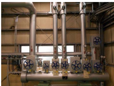
蒸気配管の改修 (滋賀工場)
