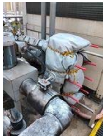
熱交換器の保温設置 (名古屋工場)
