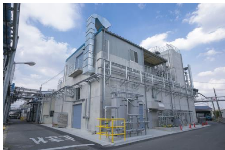
新設した廃水処理設備（名古屋工場）
