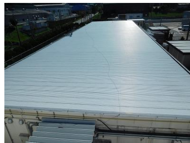
事務棟の遮熱塗装（滋賀工場）
